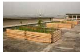
写真1 ビオトープパッケージ全景
