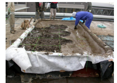
図3 荒木田土をはる様子
