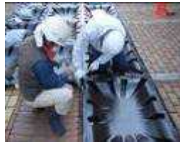
図8 パネルの接着
