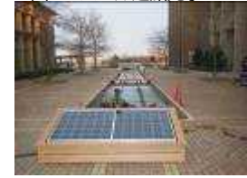
図11 システム完成
