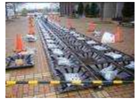
図9 パネル連結完了
