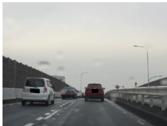
図 2 危険な場所の写真 (縦断勾配)
