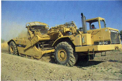
大型重機による大規模な土工事。
