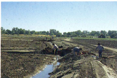
水田式灌漑用の土手をつくる。サクラメント北部はカリフォルニア米の水田が多く、その水田の灌漑方式をCottonwood(ポプラの類)の植栽地に応用した。
